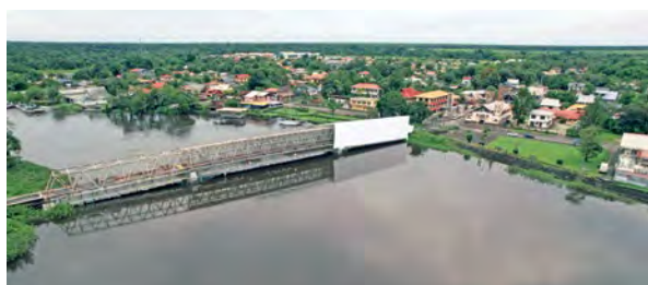
Le pont a été en partie recouvert d'une bâche avant de procéder au décapage puis à la pose d'une nouvelle couche de peinture pour éviter toute pollution du fleuve Sinnamary.
